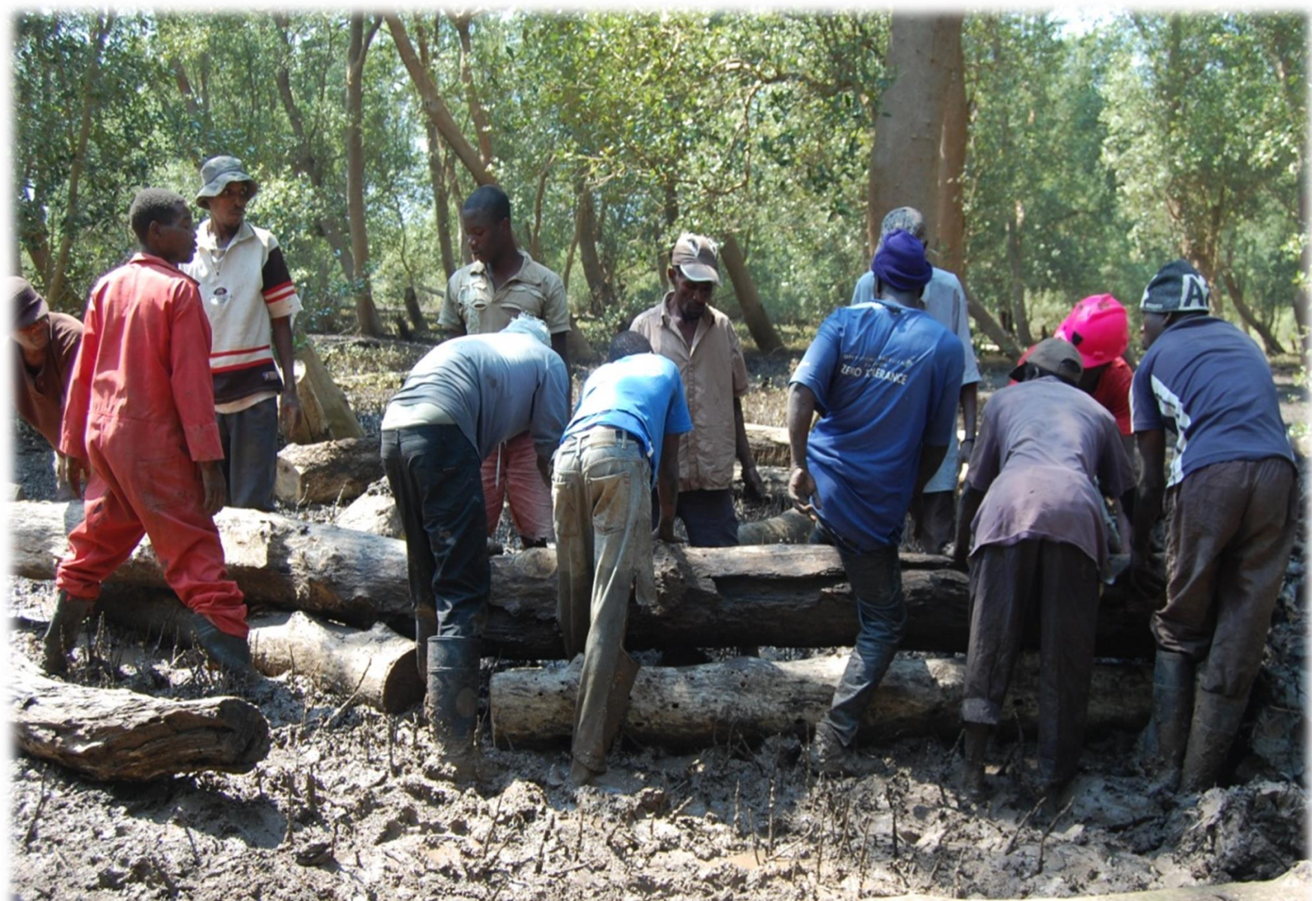
Carregamento de troncos para construção da barragem
