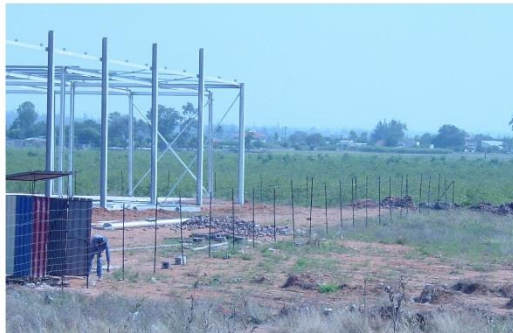
Figura 14. Atenção de áreas de mangal para construção do Centro Comercial Super Marés, na Costa do Sol, Cidade de Maputo
